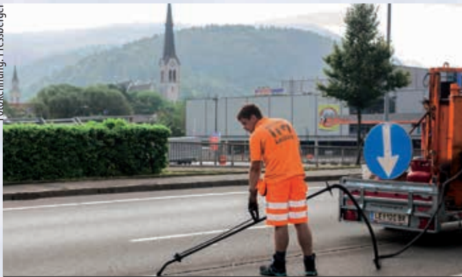
Das Budget für Straßensanierungen umfasst 2025 rund 1 Million Euro. Saniert werden beispielsweise die Homanngasse, Schillerstraße, etc.
