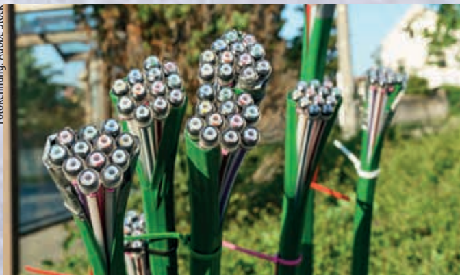
Gleichzeitig mit dem Fernwärme-Netz wird auch der Ausbau des LWL-Netzes in Zusammenarbeit mit der Citycom vorangetrieben.
